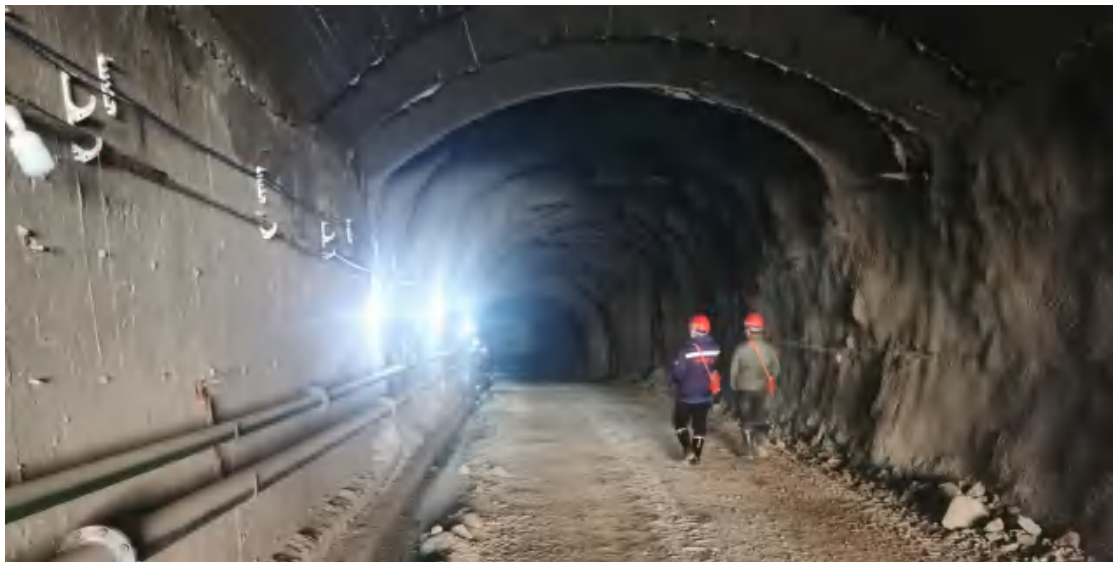
井下运输巷道
