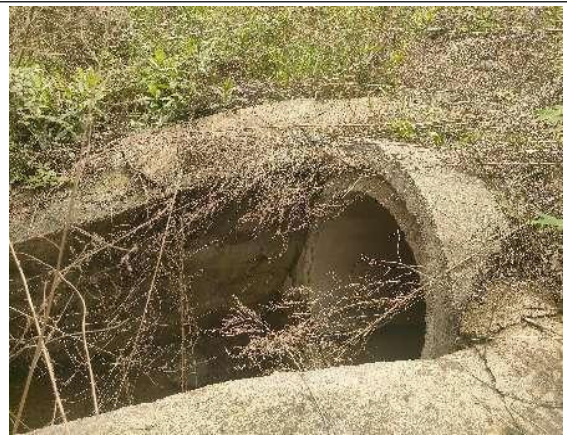
排水涵管出口
