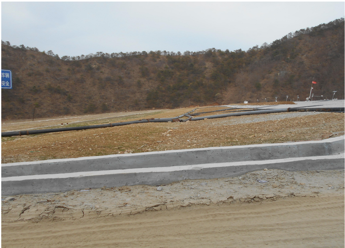
照片 4：堆积坝外坡面
