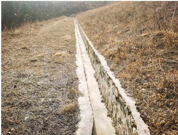
照片 6 子坝马道和坝面排水沟
