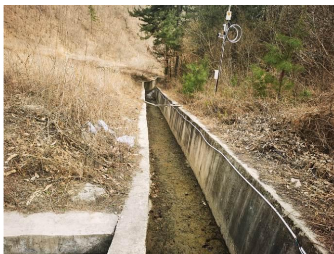
照片 2 右坝肩排水明渠
