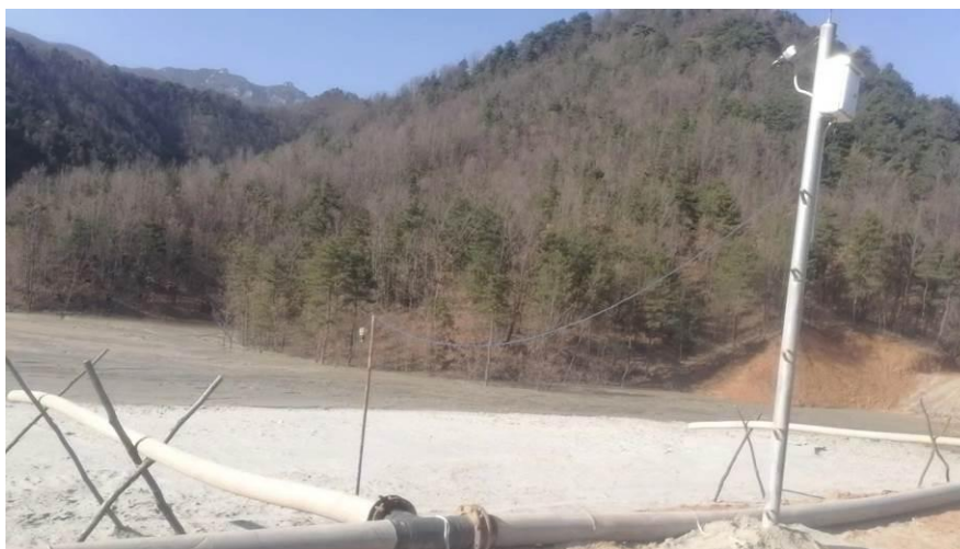
照片 16 干滩物位计和测距仪
