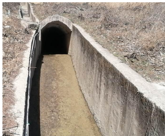
照片 11 2#排水隧洞出口
