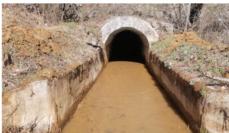
照片 9 原排水隧洞出口
