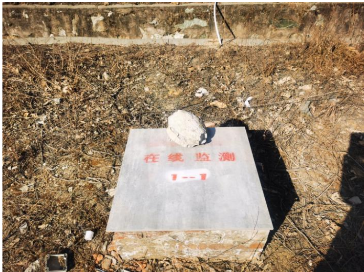
照片 14 内部位移和浸润线观测设施
