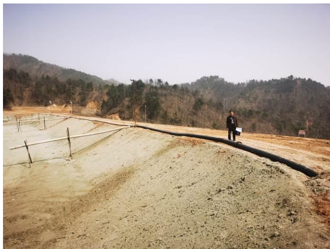
照片 3 堆积坝顶
