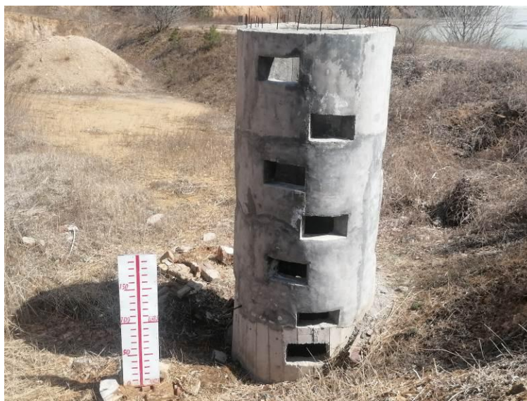
照片 8 原 2#排水井
