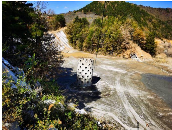
照片 10 库内右侧排水井和排水斜槽
