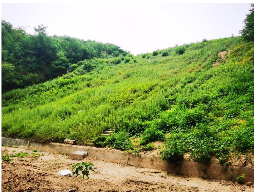
照片 1 初期坝外坡照片
