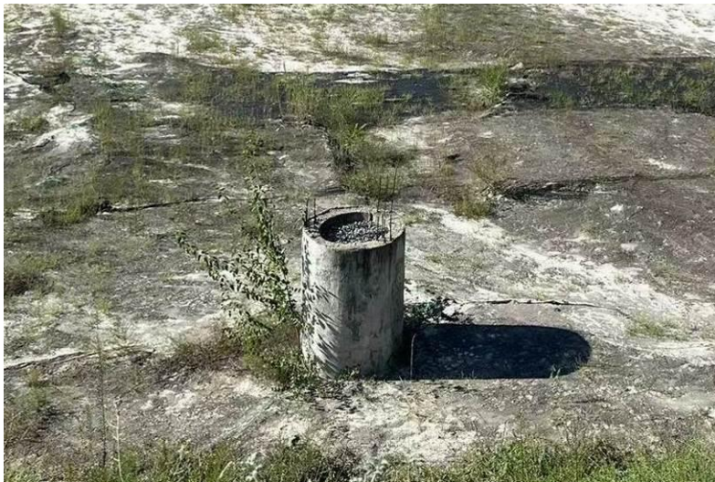
照片 9 1#排水井已封堵
