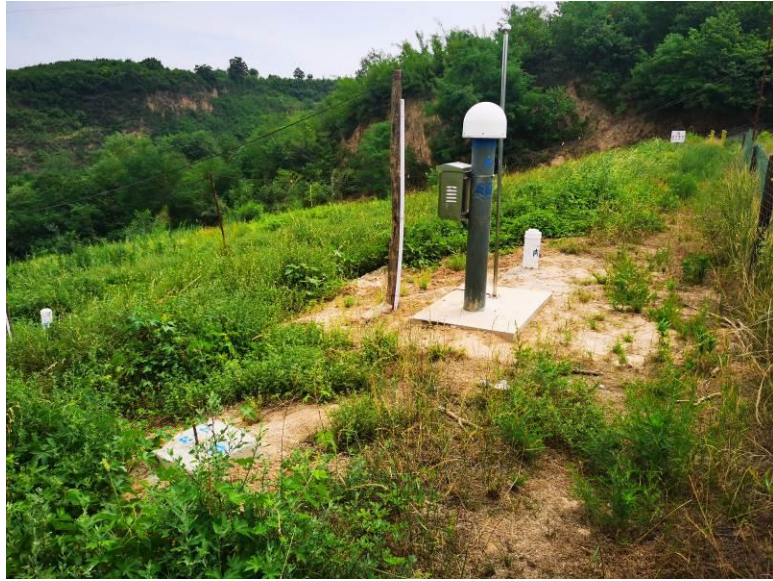
照片 13 新增表面位移和内部位移
