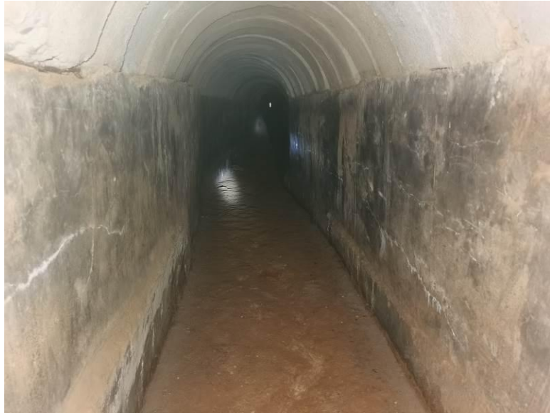
照片 8 排水隧洞
