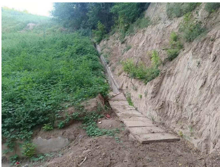
照片 2 左岸坡削坡
