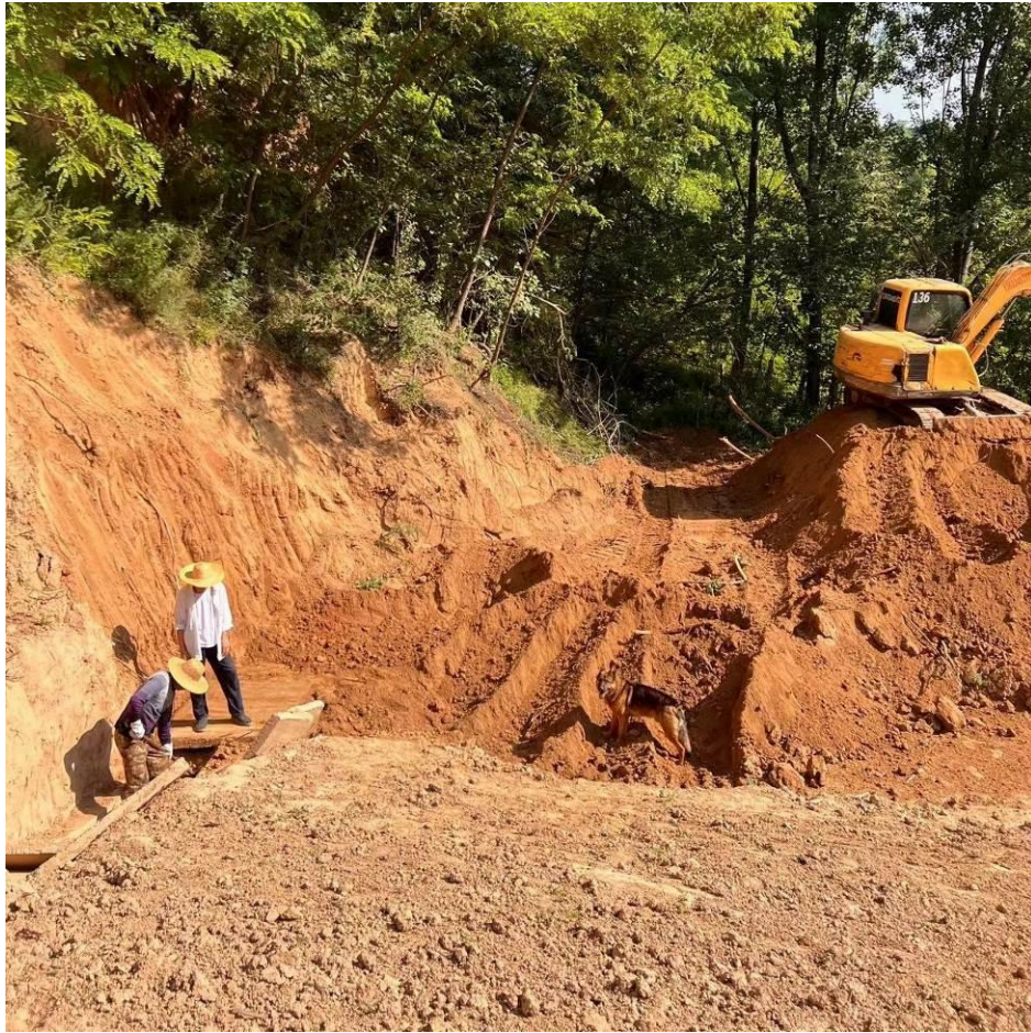
照片 3 初期坝左岸削坡及坝肩沟清理
