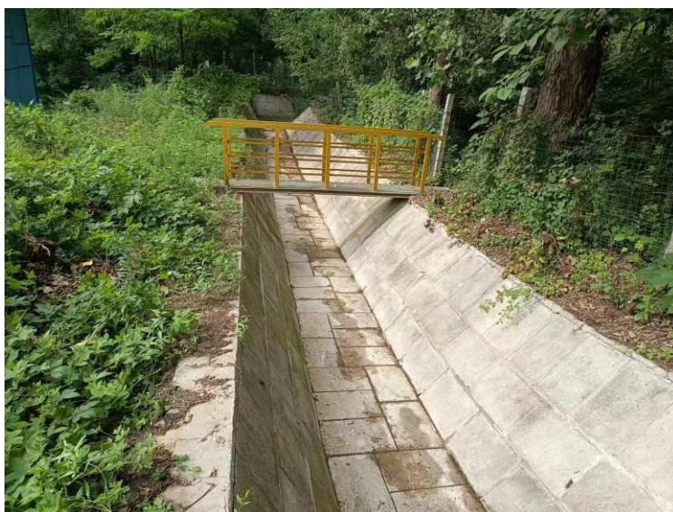
照片 3 坝肩沟修复
