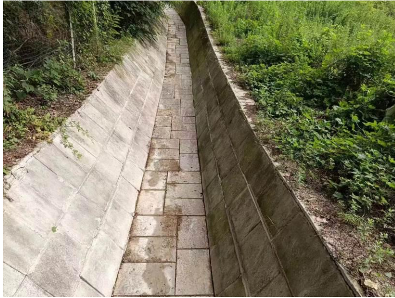
照片 5 右坝肩截水沟（右侧溢洪道）
