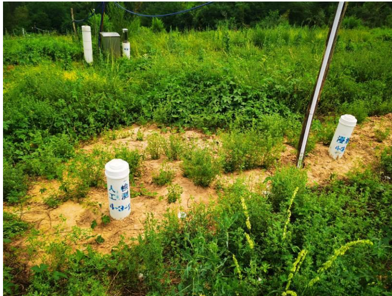
照片 14 新增浸润线观测管
