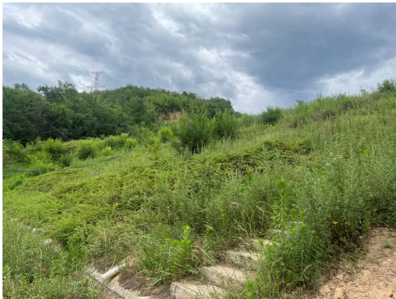
照片 4 堆积坝外坡
