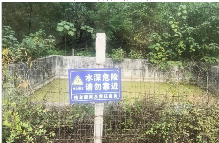
照片 20 回水池新增警示标志
