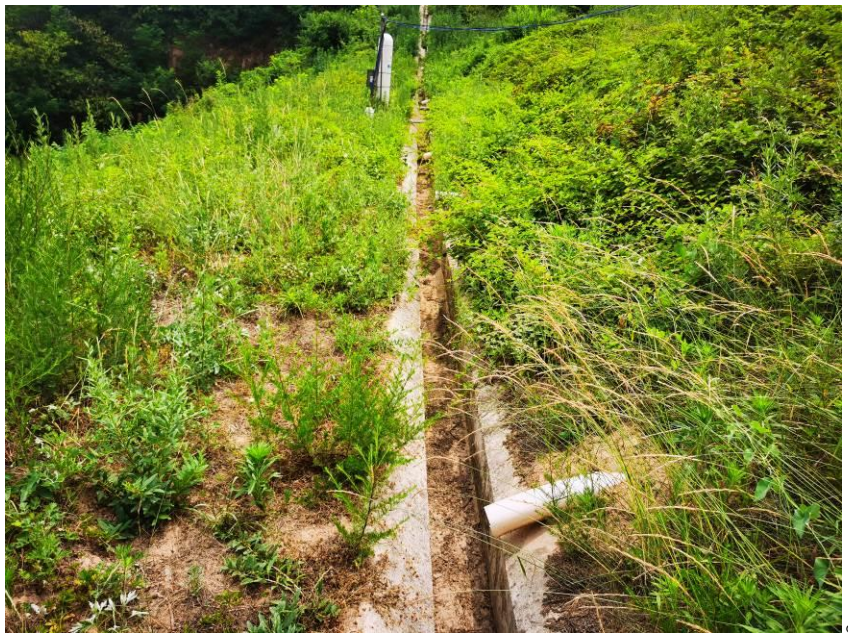
照片 11 初期坝顶新增排渗管
