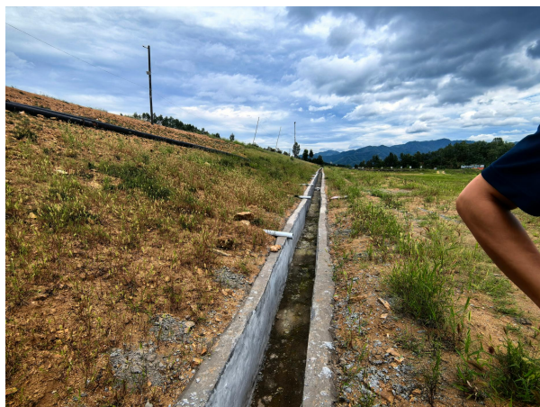
照片3 堆积坝坝面排水沟
