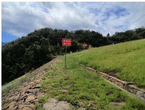
照片 2 坝面排水沟、初期坝顶
