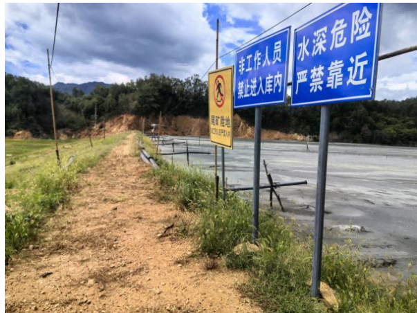
照片4 堆积坝顶
