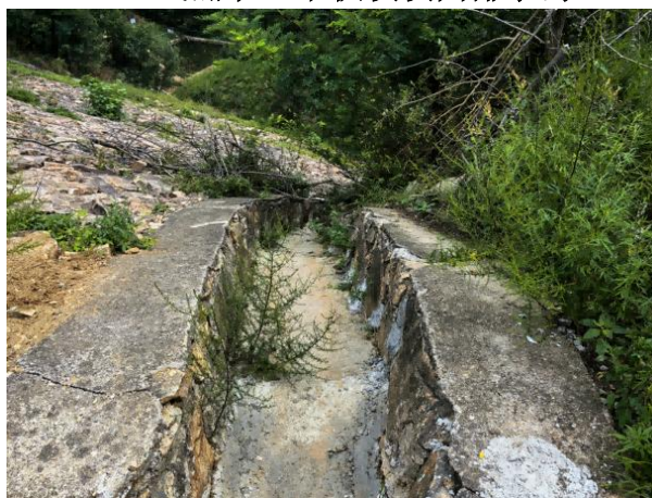
照片5 初期坝坝肩截水排水沟
