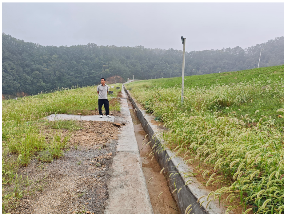
照片 5 堆积坝马道
