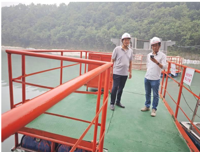
照片 8 3#排水井及浮桥
