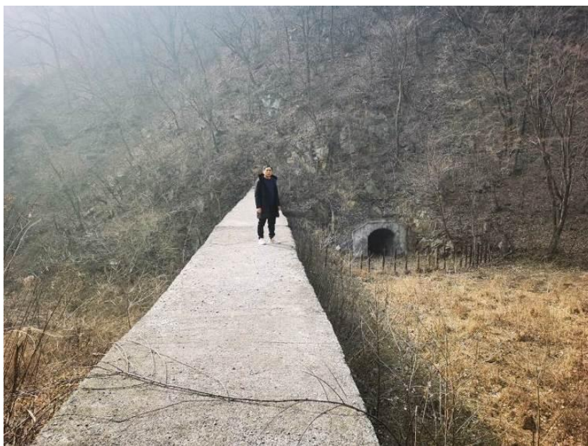
照片 7 拦洪坝及分洪隧洞
