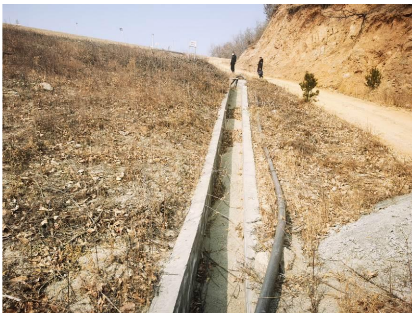
照片 12 上坝道路及右坝肩截水沟
