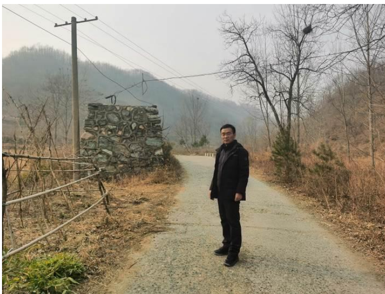
照片 1 浆砌挡墙
