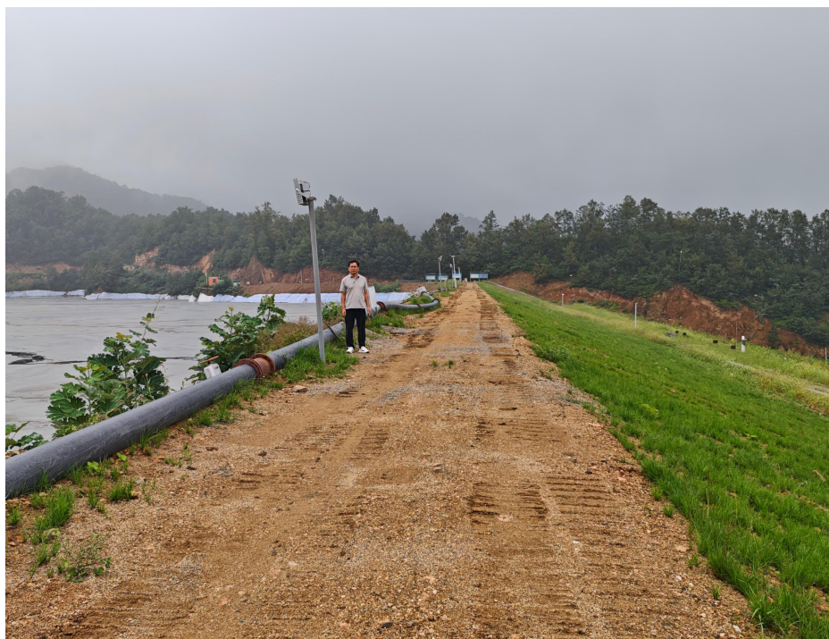
照片 4 堆积坝顶
