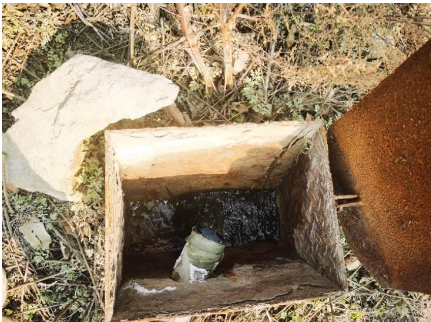
照片 6 排渗管集水
