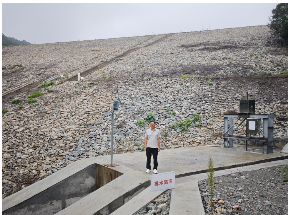
照片 2 初期坝外坡
