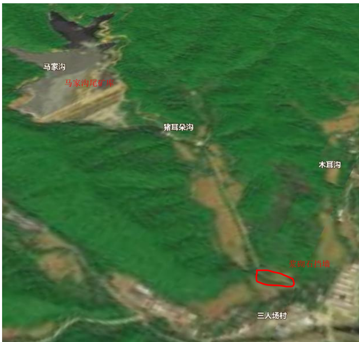
图 2-2 马家沟尾矿库卫星图
