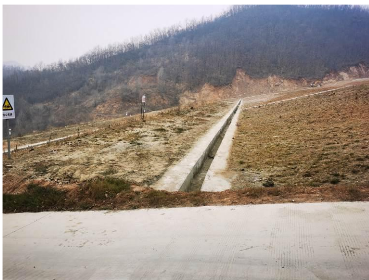
照片 3 堆积坝外坡及马道
