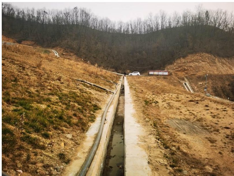
照片 4 排渗管及横向排水沟
