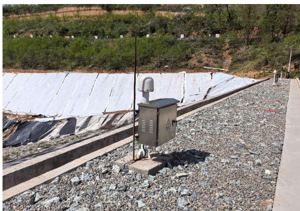
照片 25 外部位移监测
