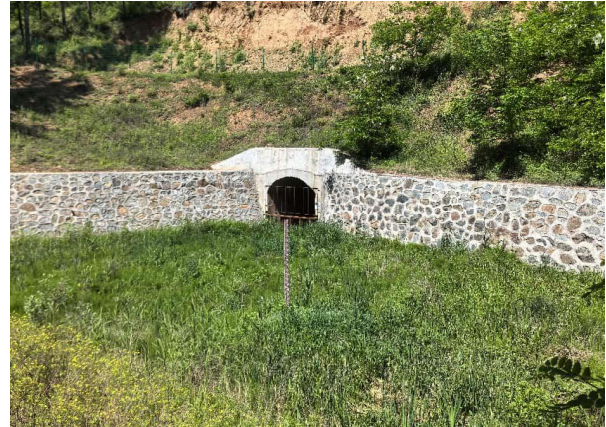
照片 15 分洪隧洞
