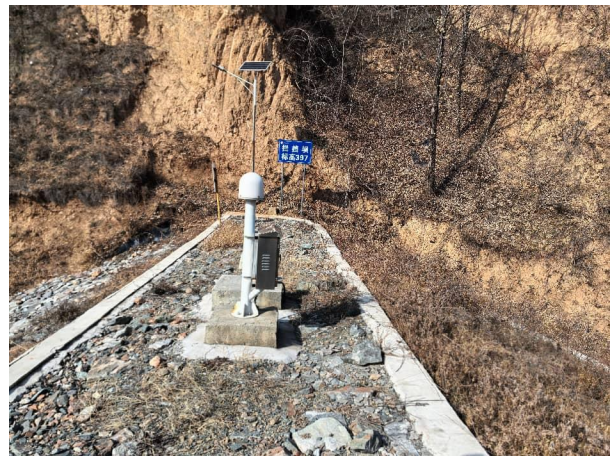
照片 7 拦挡坝顶
