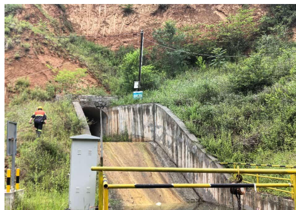
照片 17 分洪隧洞出口
