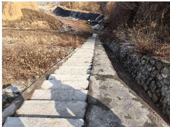
照片 5 拦砂坝外坡上坝踏步
