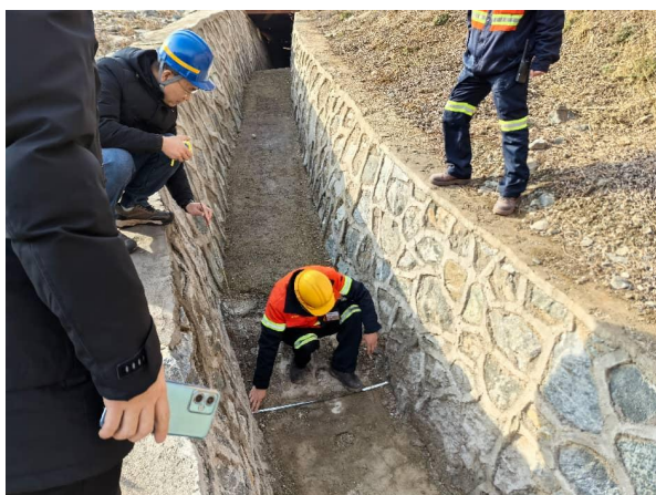
照片 4 坝肩截水沟
