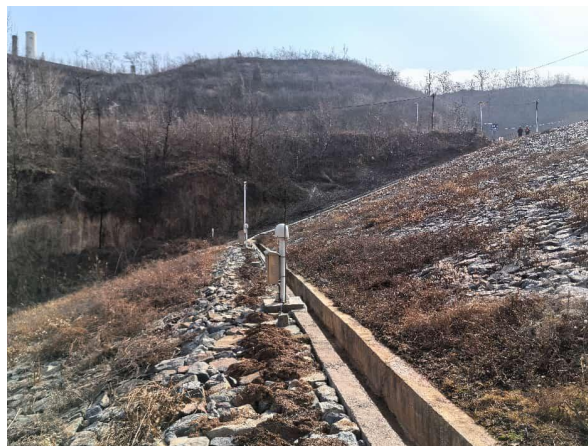
照片 3 马道排水沟
