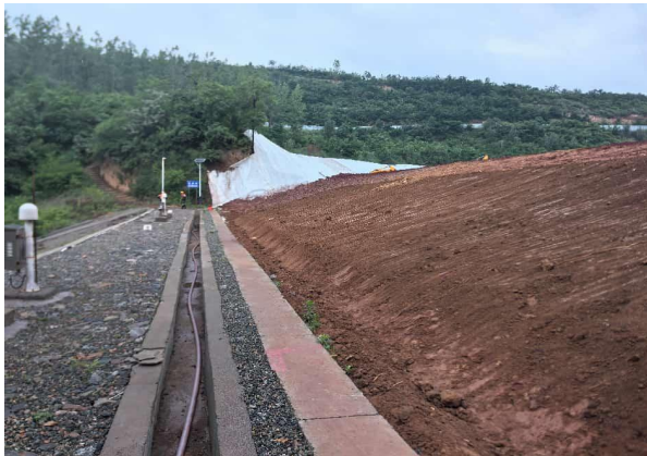
照片 16 拦洪坝顶
