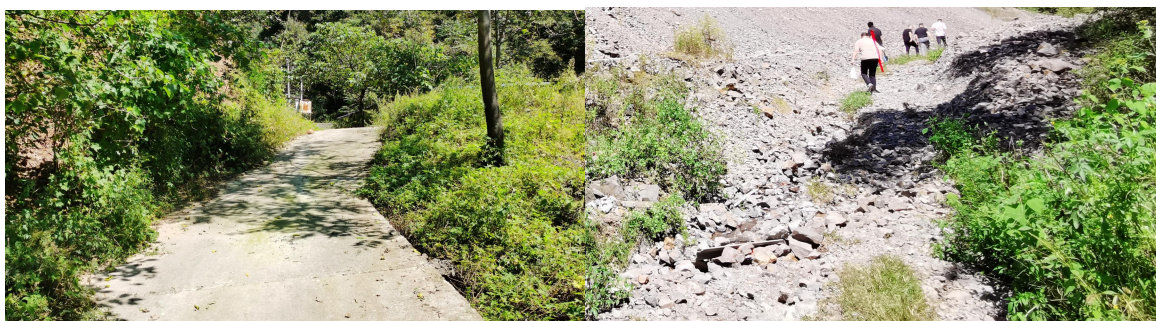
照片 2-6 已有混凝土道路（镜向 25°）
