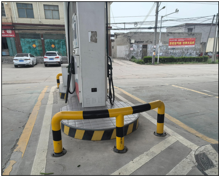
防撞柱螺栓已补齐
