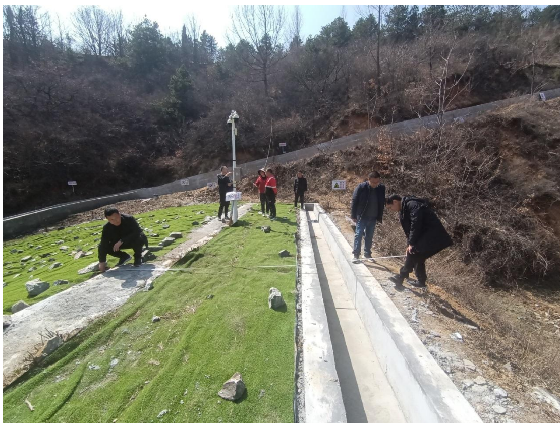
照片二十三： 评价人员实测初期坝顶宽度照片
