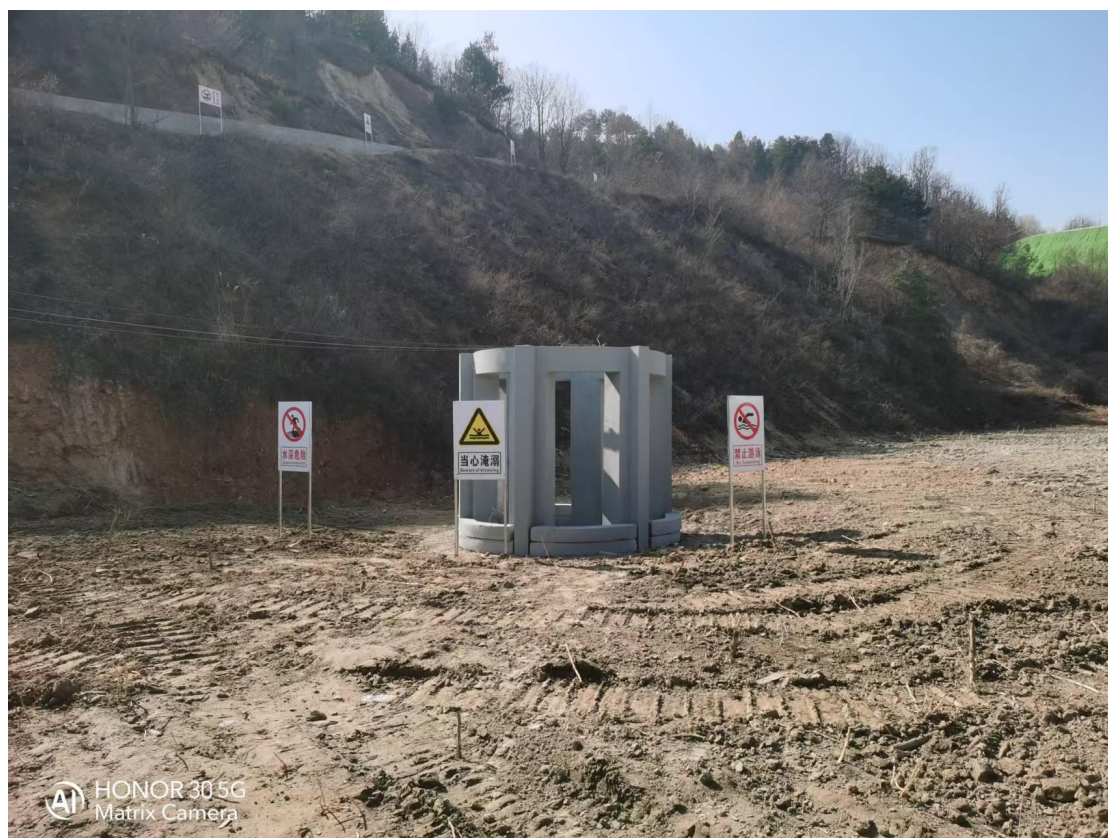
照片十：排水井现状照片
