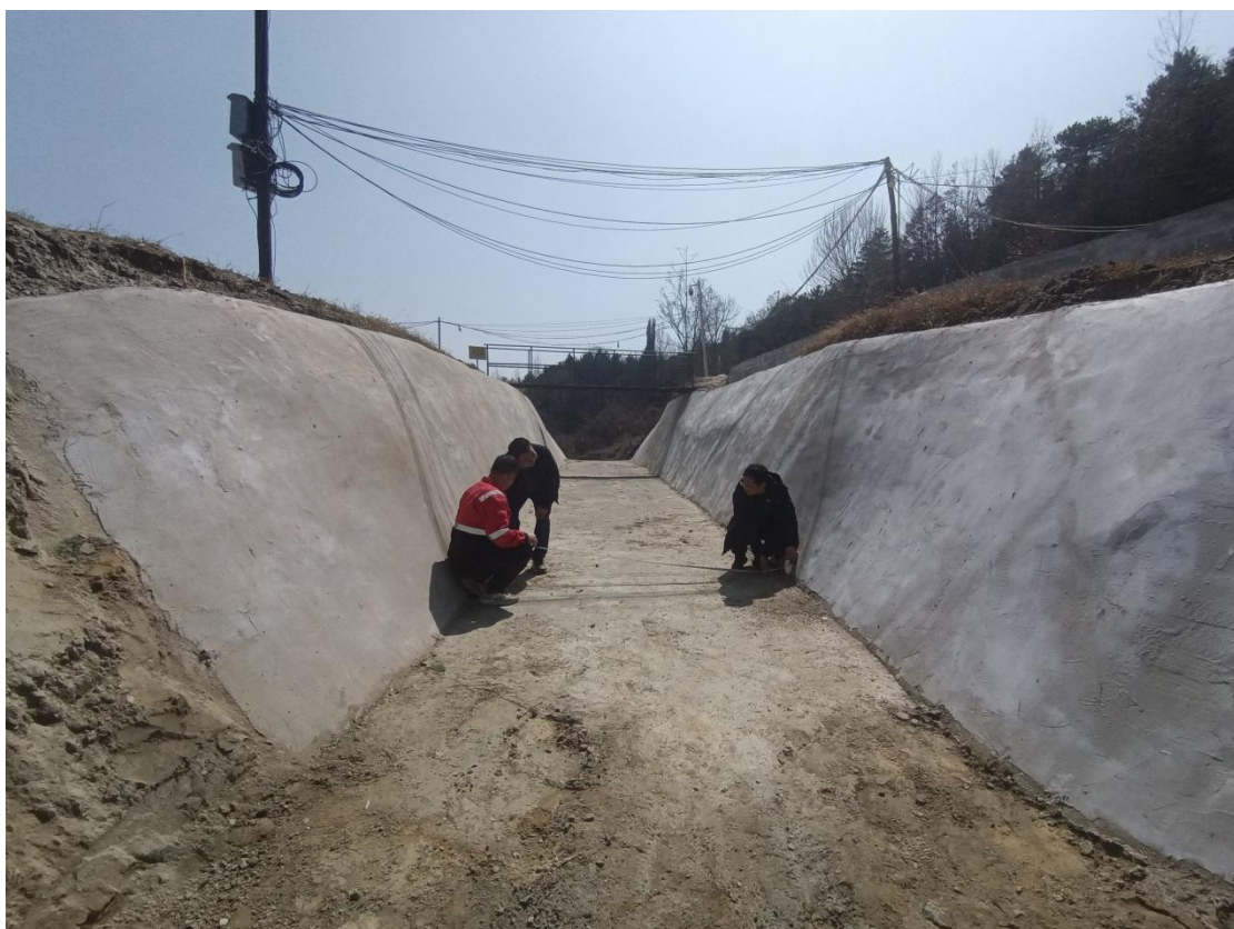
照片二十一：评价人员测量溢洪道照片
