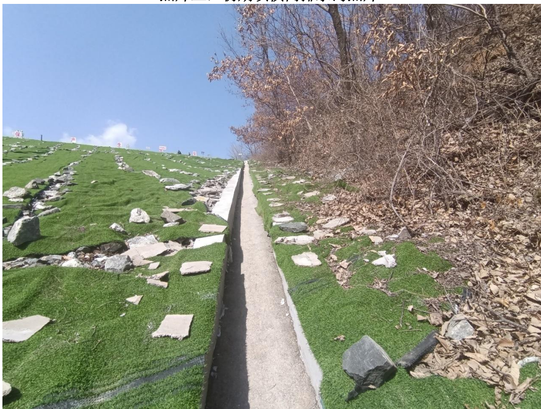
照片四：初期坝左坝肩截水沟
