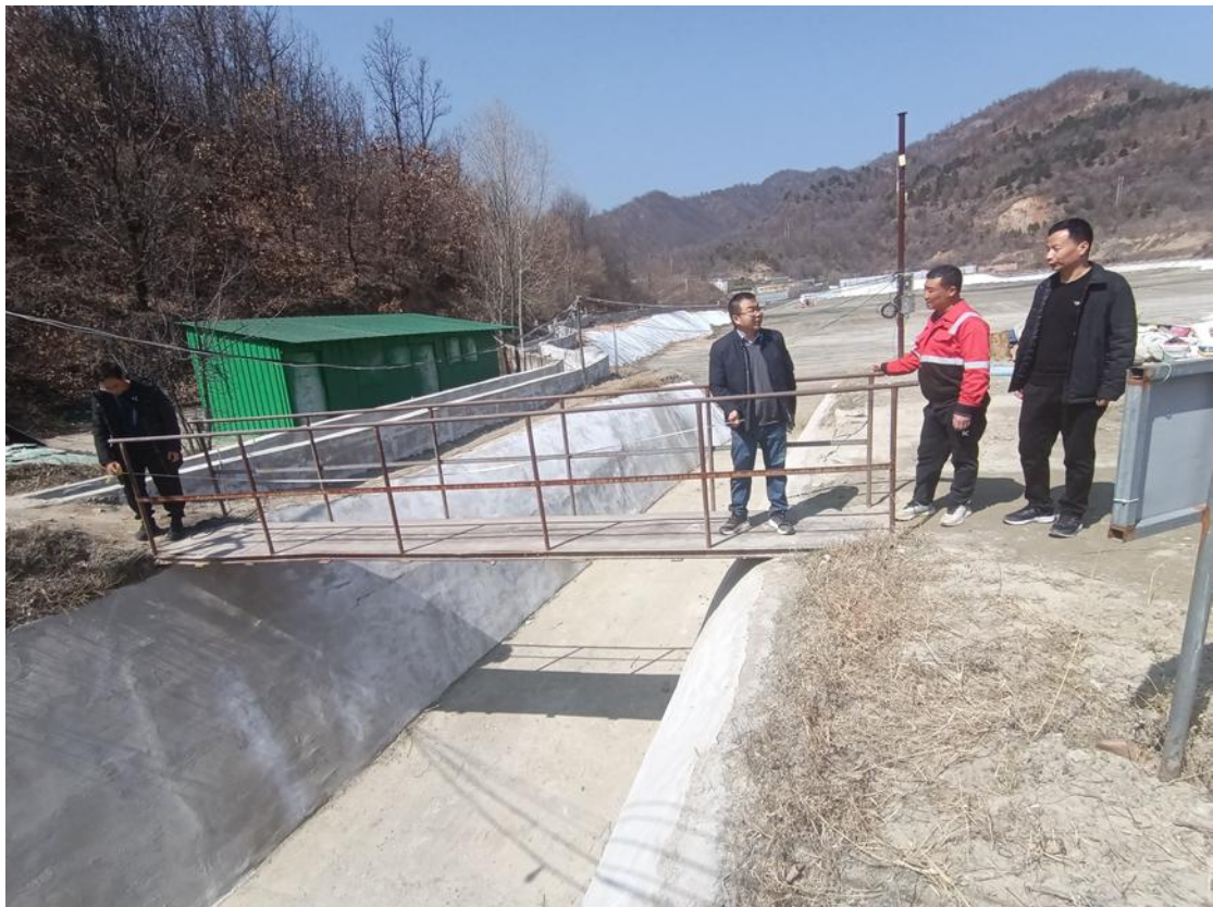
照片九：中间坝体溢洪道现状照片
