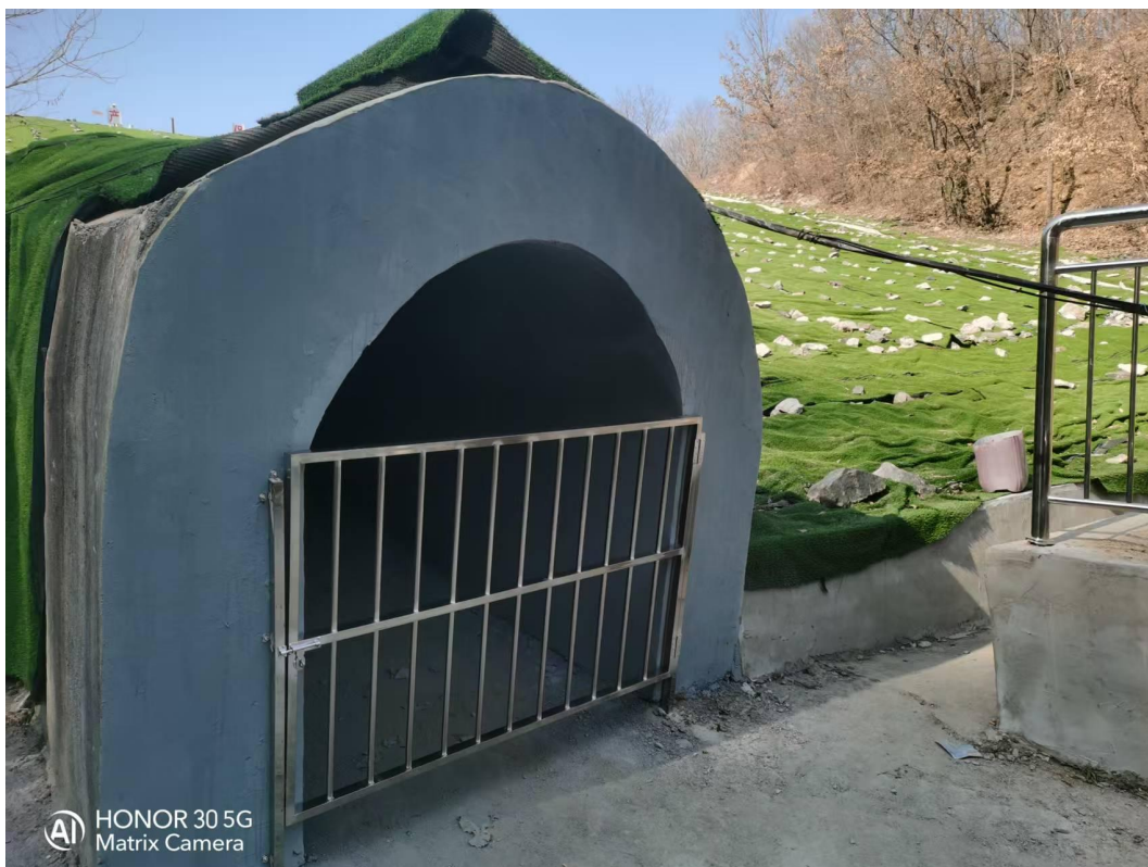
照片十一：排水涵洞出口现状照片
