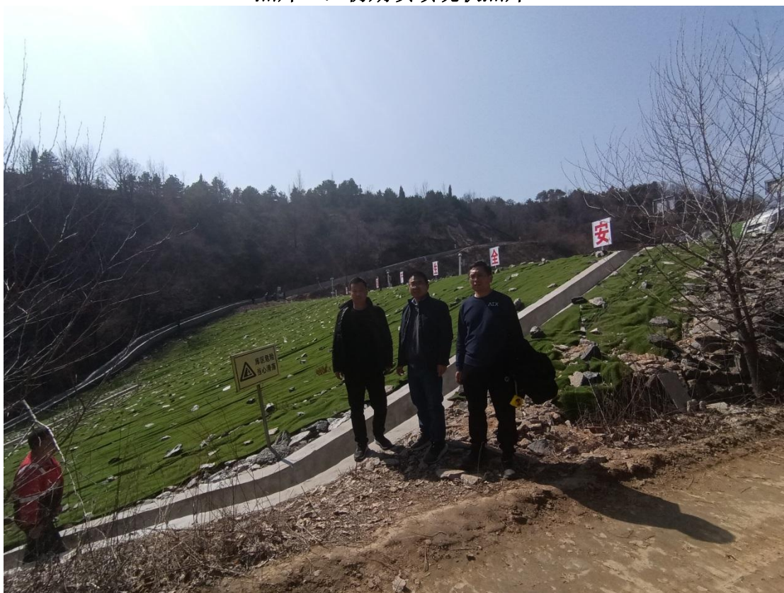
照片三：初期坝外坡现状照片
