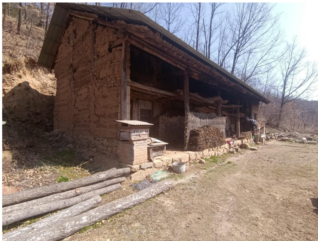
照片一：初期坝下游 200m 处房屋现状照片
