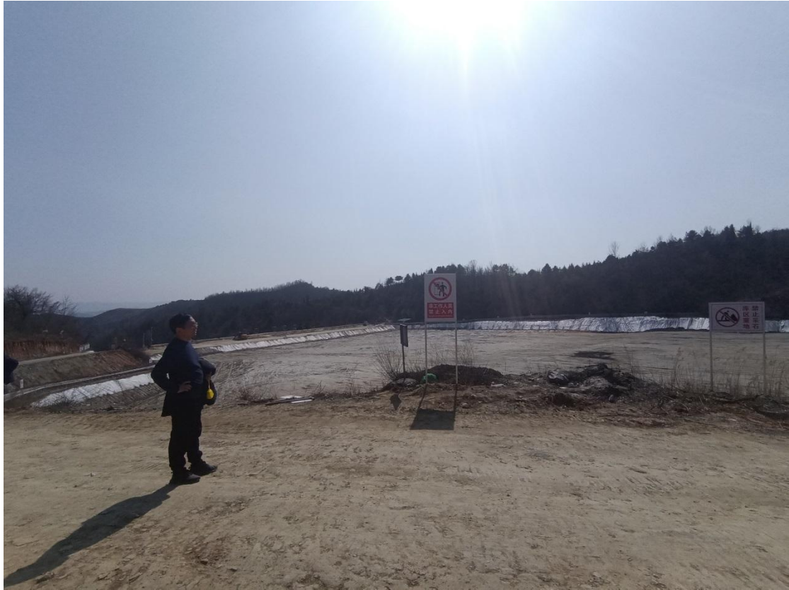
照片十六、库周防渗设施现状照片
