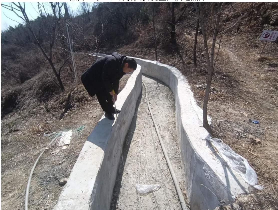
照片二十二：评价人员现场测量截洪沟断面照片
