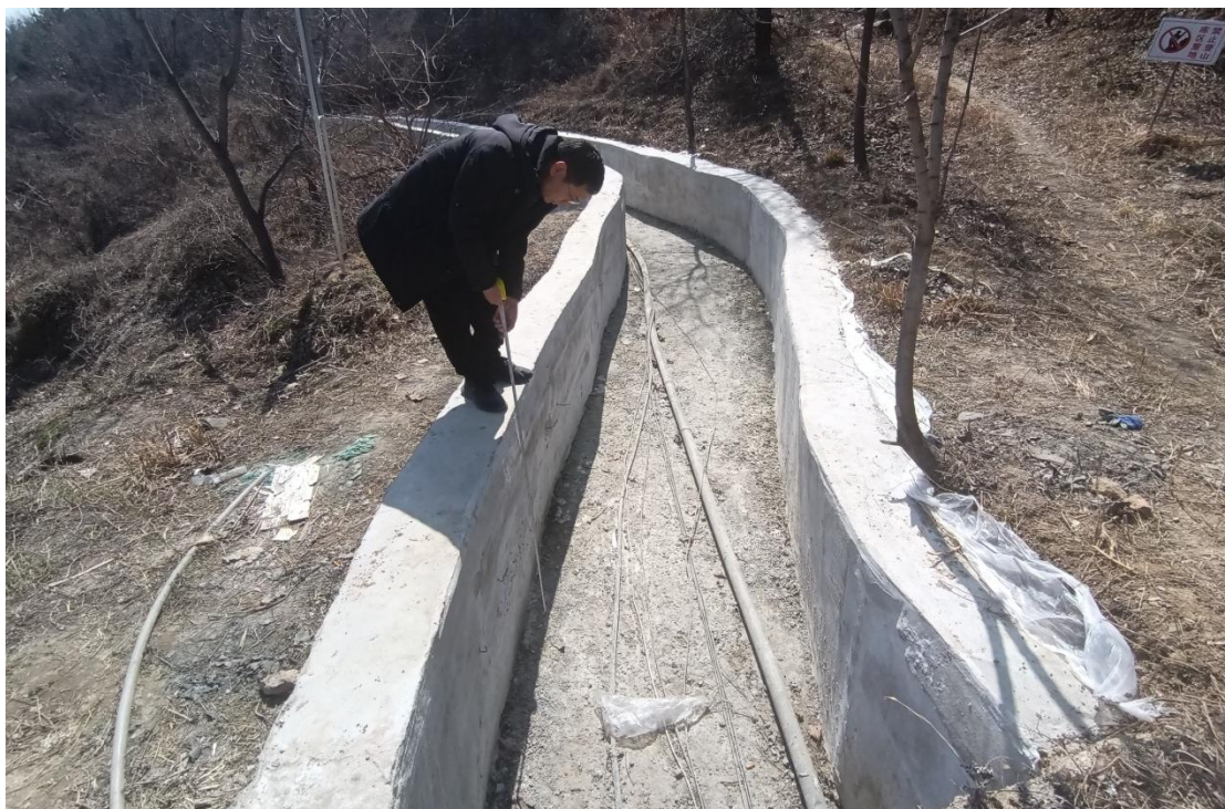
照片七：滩面右侧截洪沟现状照片
