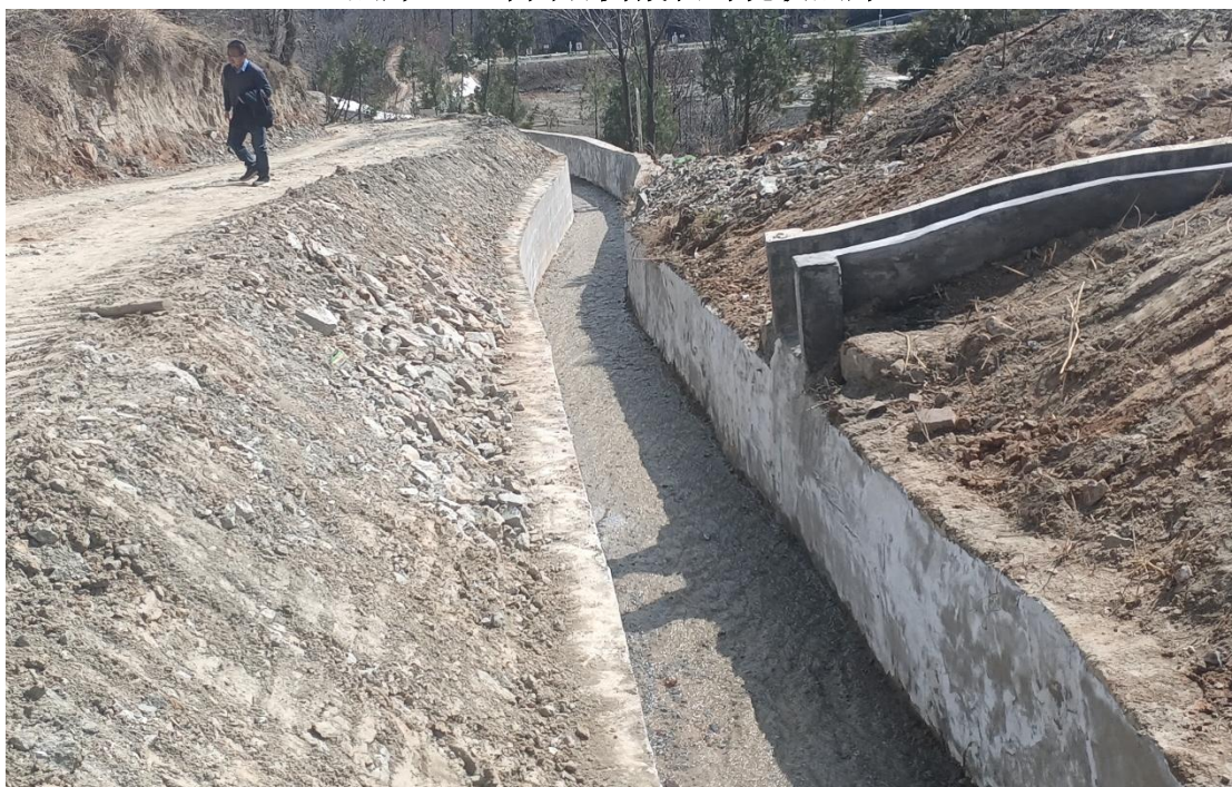
照片八：滩面左侧截洪沟现状照片
