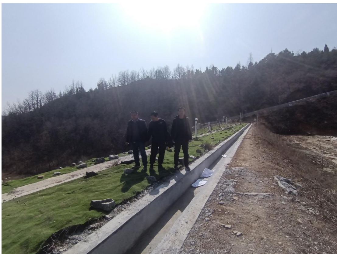
照片二：初期坝顶现状照片
