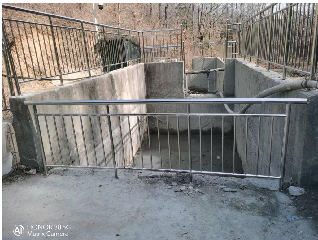
照片十二：消力池回水池现状照片
