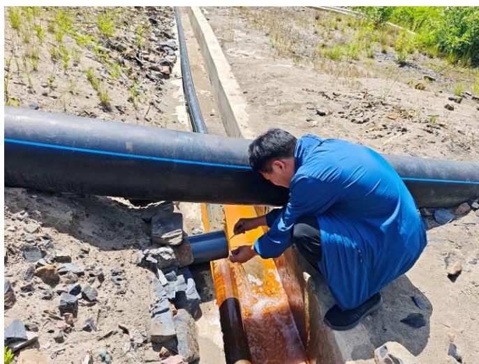
照片 4 测量集水管直径和壁厚
