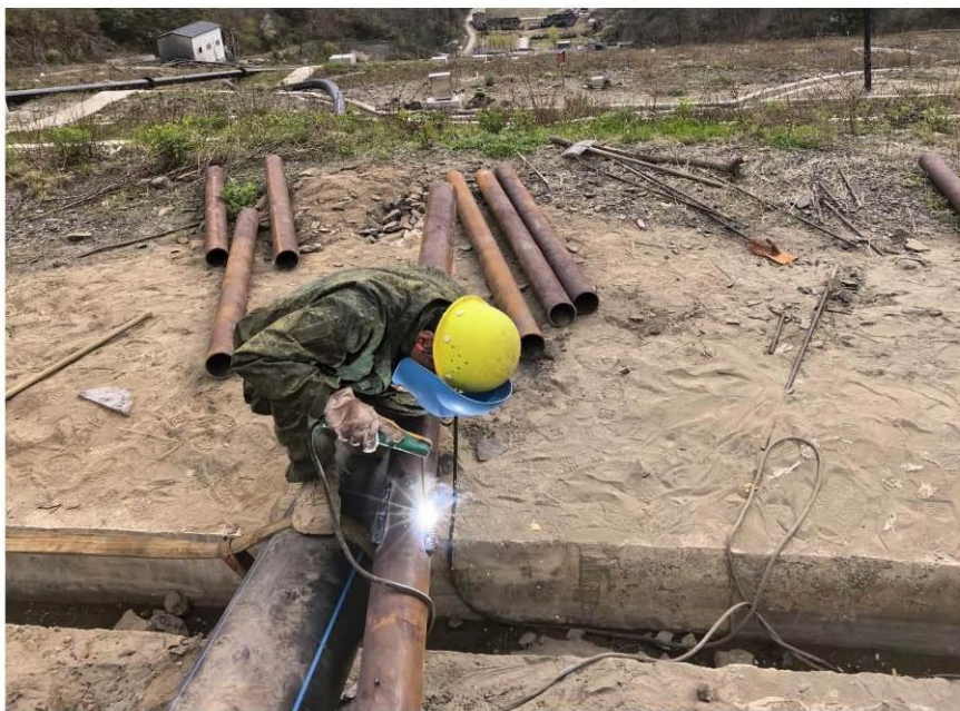
辐射井集水管、渗水管加工及施工
